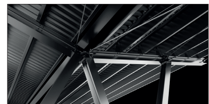
Construcción del techo
