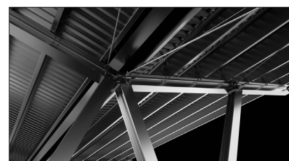
Construcción del techo
